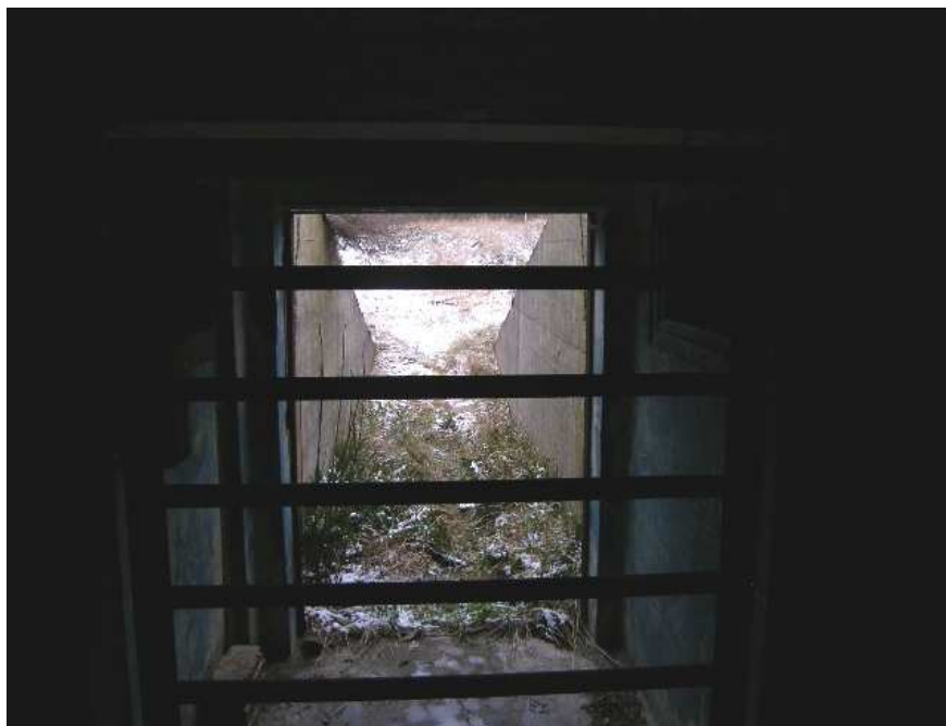
Ryc. 8. Krata zabezpieczająca wejście do zimowiska nietoperzy (fot. M. Dzięgielewska)
