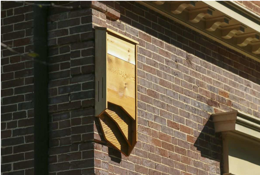
Ryc. 11. Skrzynki natynkowe dla nietoperzy montowane na budynkach zapewniają im dodatkowe i bezpieczne schronienie (źródło: www.curbed.com )
