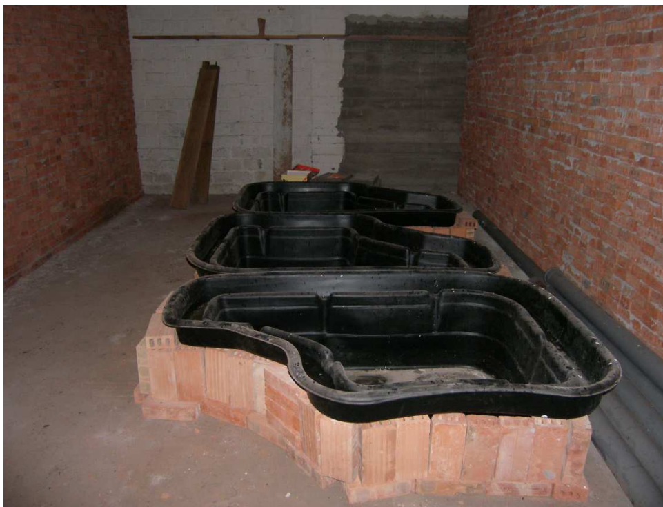
Ryc. 9. Pojemniki na wodę zamontowane w zimowisku nietoperzy dla poprawy warunków mikroklimatycznych panujących wewnątrz obiektu (fot. M. Dziągiewska)
